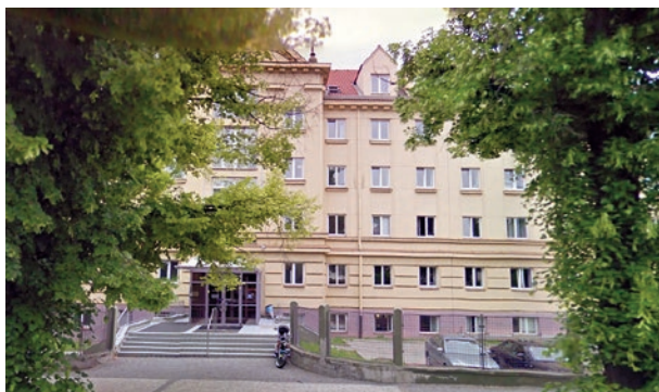
Jako nové sídlo Ústavu byla určena tzv. Nová budova tzv. Masarykovy koleje v pražských Dejvicích, pohled z června 2010.
